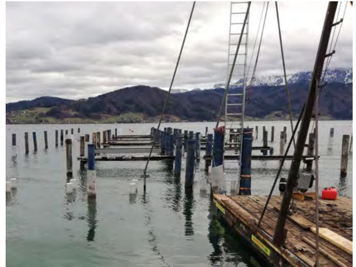
**A- und B-Steg sind in Arbeit.** Der Belag der Stege A und B ist auf diesen Bildern weitgehend abgetragen, die ersten Piloten mit Edelstahlrohren saniert. Die Takelleiter steht auf dem rechten Bild noch ohne Stegverbindung im Wasser
