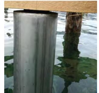
**Edelstahlrohr.** Schützt das Holz an der Wasserkante
