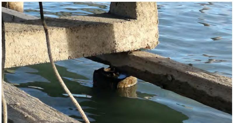
**Nach 50 Jahren erodiert.** Die Holzverbindungen der Unterwasser-Konstruktion lösen sich langsam aber sicher auf
