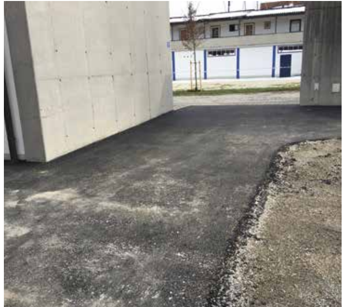
Frischer Asphalt. Ein glatter Untergrund erleichtert das Bewegen von Lasten auf Rollen bei An- und Abtransport
