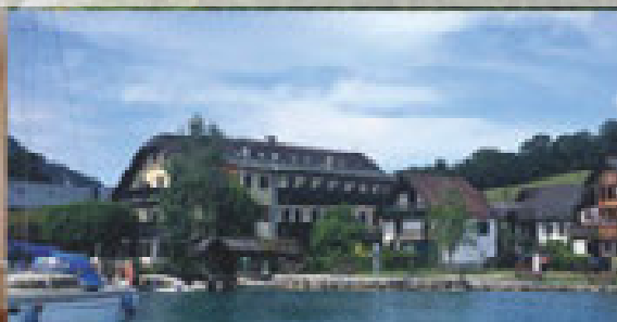
Wohnungsneubau am Attersee
